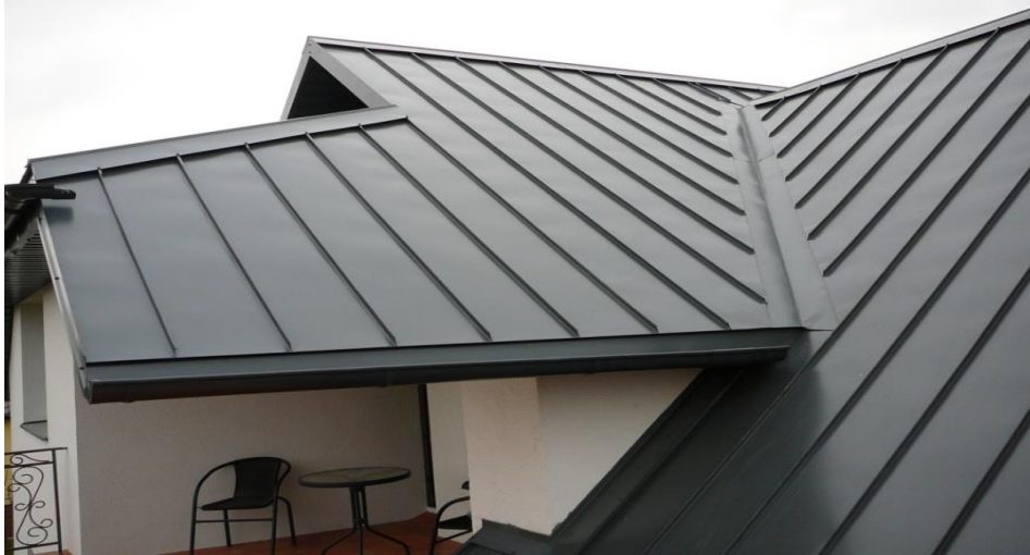
Sąlaja – 2 stogo plokštumų sudūrimo vieta.
